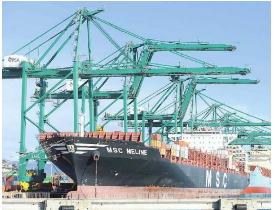
Al terminal Psa di Genova-Pra' l'elettrificazione delle banchine sarà pronta a gennaio
